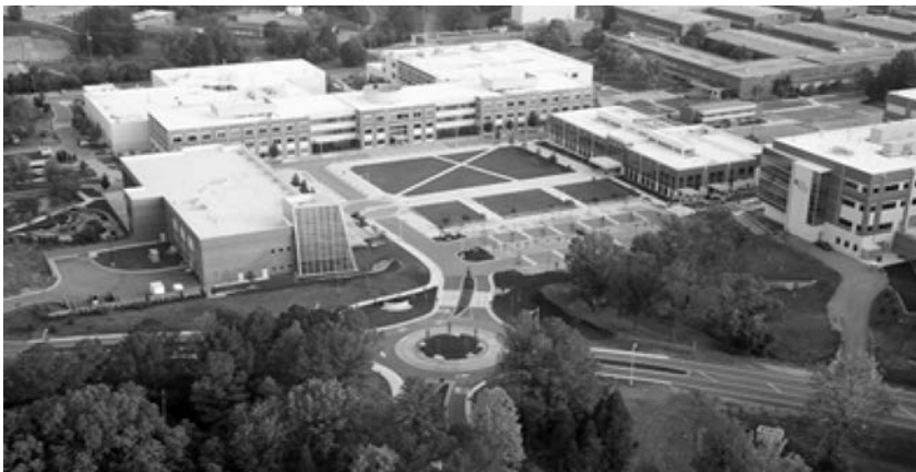
Şekil 3: Oak Ridge National Laboratory, TN, USA.
